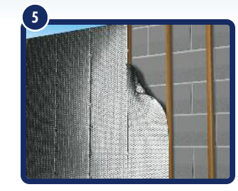
Masonry Wall / Mur en maçonnerie / Pared de mampostería
